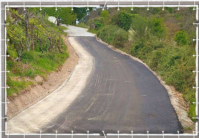
Repavimentação e Requalificação da Estrada Municipal de Castro Cio - Ferreiros de Tendais
