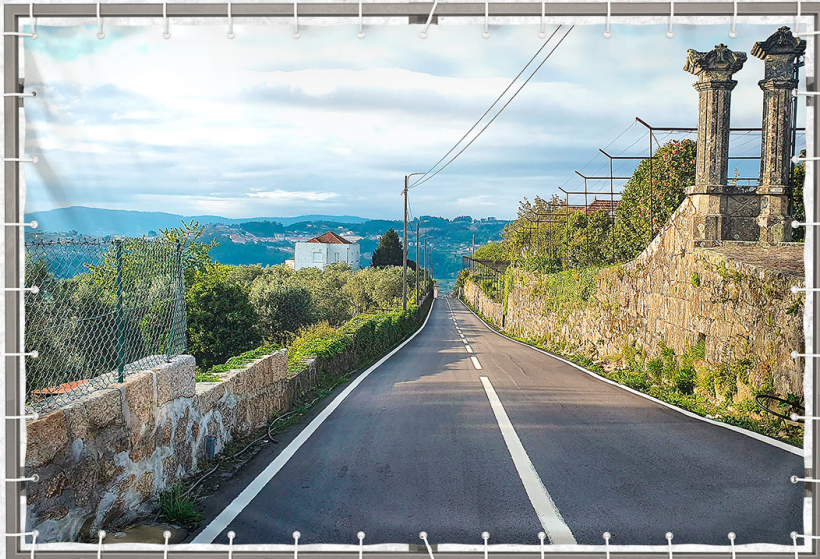
Requalificação de Vias Sujeitas a Intervenção de Água e Saneamento - EN222 a Saímes
