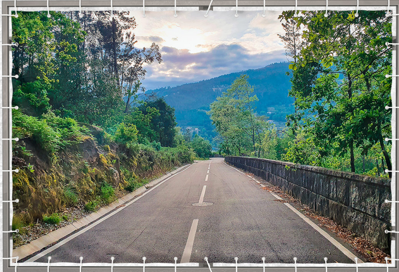
Requalificação de Vias Sujeitas a Intervenção de Água e Saneamento - Cruzamento de Saímes a Alcocreiros
