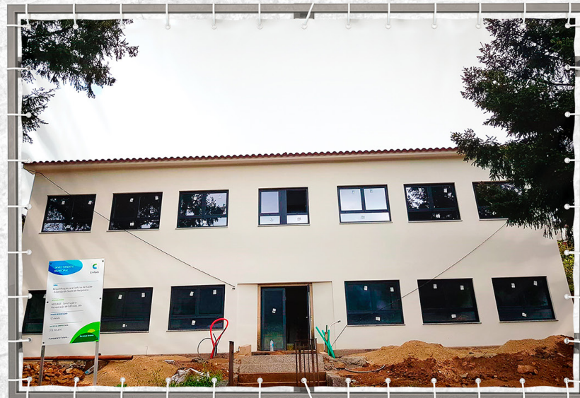
Requalificação para Edifícios de Saúde - Extensão de Saúde de Nespereira
