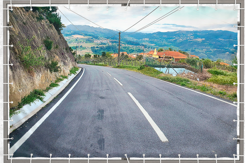
Requalificação de Vias Sujeitas a Intervenção de Água e Saneamento - Cruzamento de Saímes - Rua das Almas
